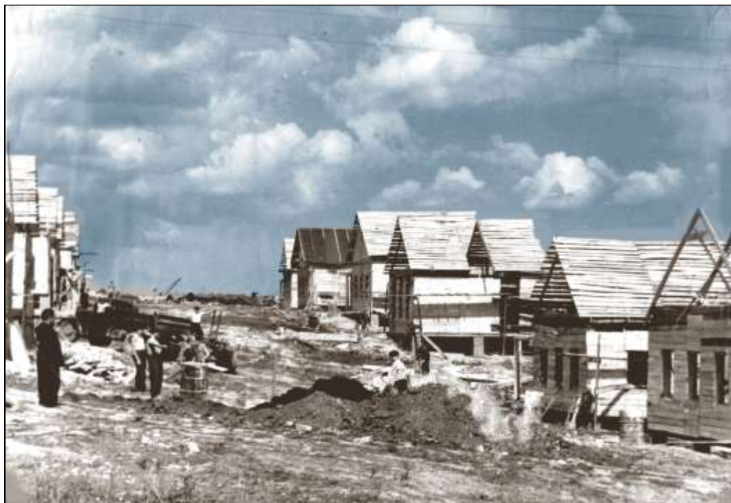
Строительство жилых домов для работников завода на Левином поле
