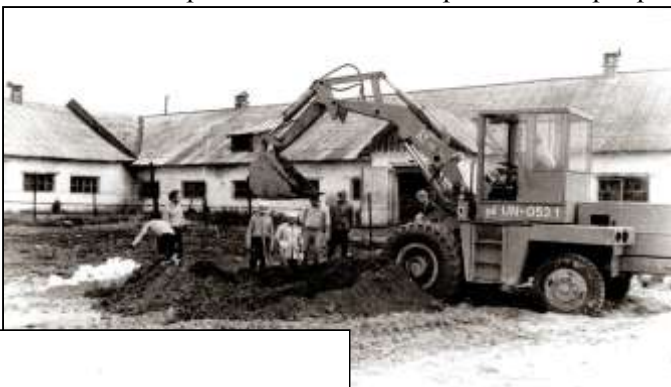
Строительные работы в заводском подсобном хозяйстве (цех №39, деревня Лунёво)
